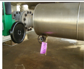
Fig.1 Defecte drainafsluiter
